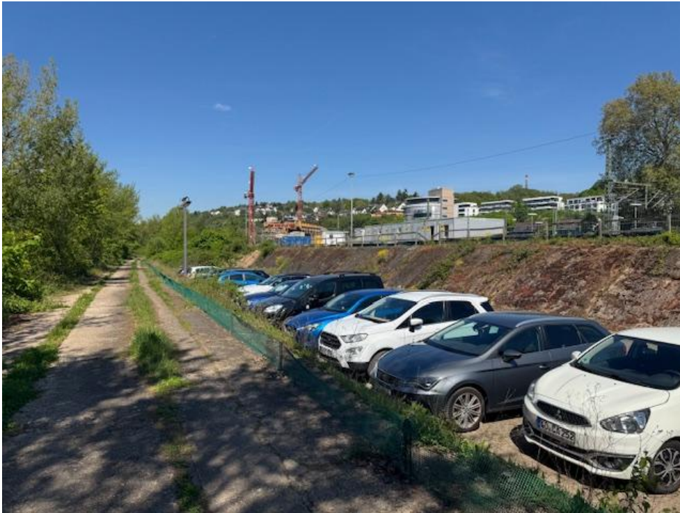
Abbildung 1: Plangebiet B-Plan Rheinufer Nord, der Standort des geplanten Parkhauses wird aktuell als Parkplatz genutzt. Im Hintergrund die Baustelle zur K82.
