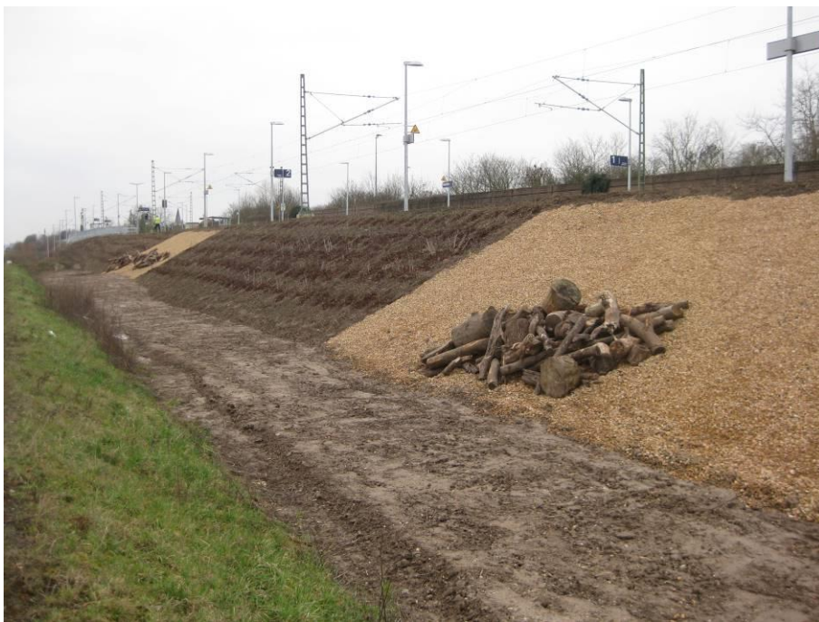
Abbildung 8: Beispiel einer reptiliengerecht gestalteten Bahnböschung
